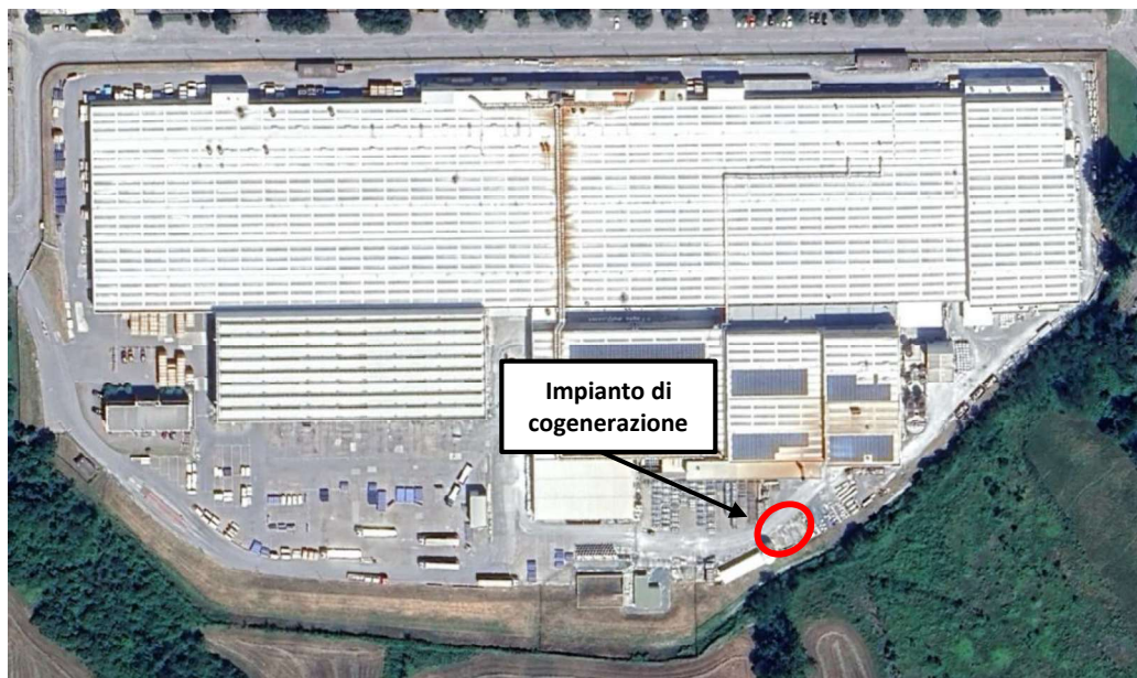
Fig.2 - Fig. 2 - Particolare dell'area dove sarà installato l'impianto di cogenerazione.
